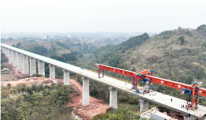
成渝中线高铁4标467孔正线箱梁架设施工现场。中铁三局供图
