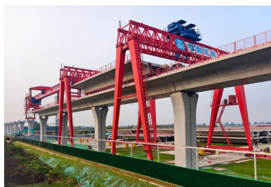
三星堆梁场往濠阳站方向的成德线高架段架梁现场。
