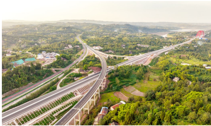
镇广高速通江至广安段俯瞰。蜀道集团供图
