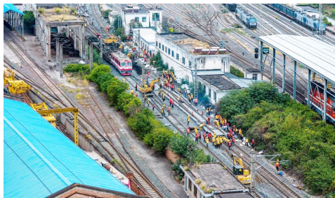
11月19日成昆铁路西昌南站换岔施工现场。中国铁路成都局集团成都工务大修段供图
