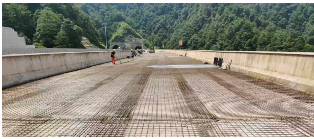
▲ 乐西高速环路热管施工过程。
