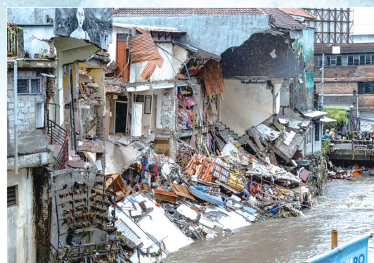
2025年9月10日,印度尼西亚巴厘岛登巴萨遭洪水侵袭被破坏的建筑。
