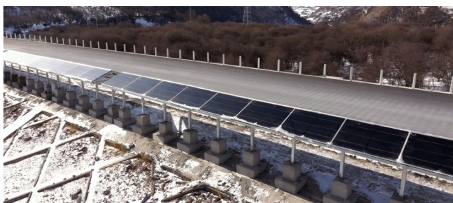
化镭发电玻璃。受访者供图 久马高速试验段安装的碲化镭发电玻璃。
