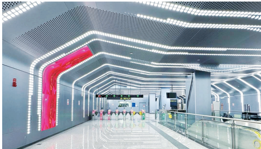
30号线一期金融城北站。成都轨道集团供图
