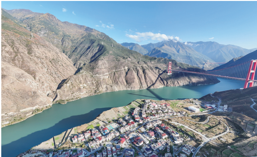
这是11月6日在泸定县泸定水电站库区拍摄的“引大济岷”工程取水口大致方位(无人机照片)。
