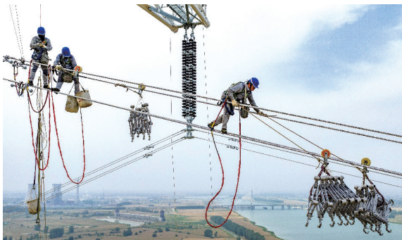
安徽送变电工程有限公司施工人员在百米高空进行淮河大跨越作业。
