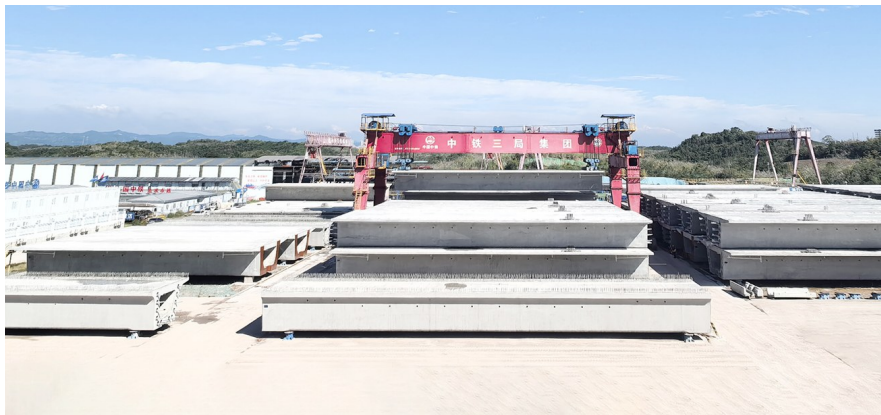
成渝中线高铁成都东部新区制梁场完成478孔箱梁预制任务。中铁三局供图
