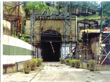
1997年，503地下战备电厂入口。图据攀枝花市西区档案馆
