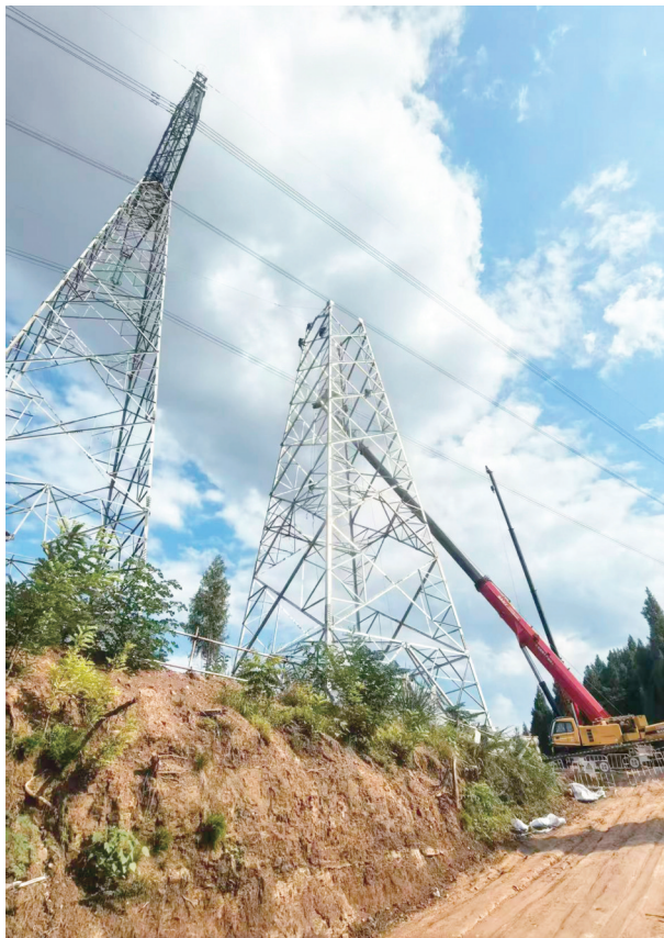
施工方对高压线实施迁改。
