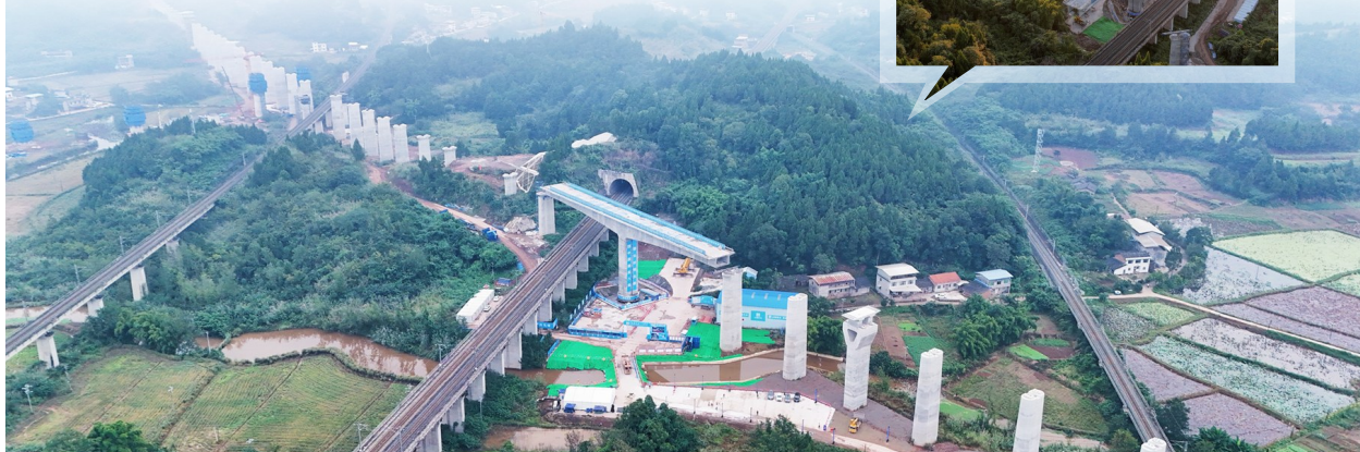
梁体转体后,上跨既有沪蓉铁路。成达万高铁公司供图
