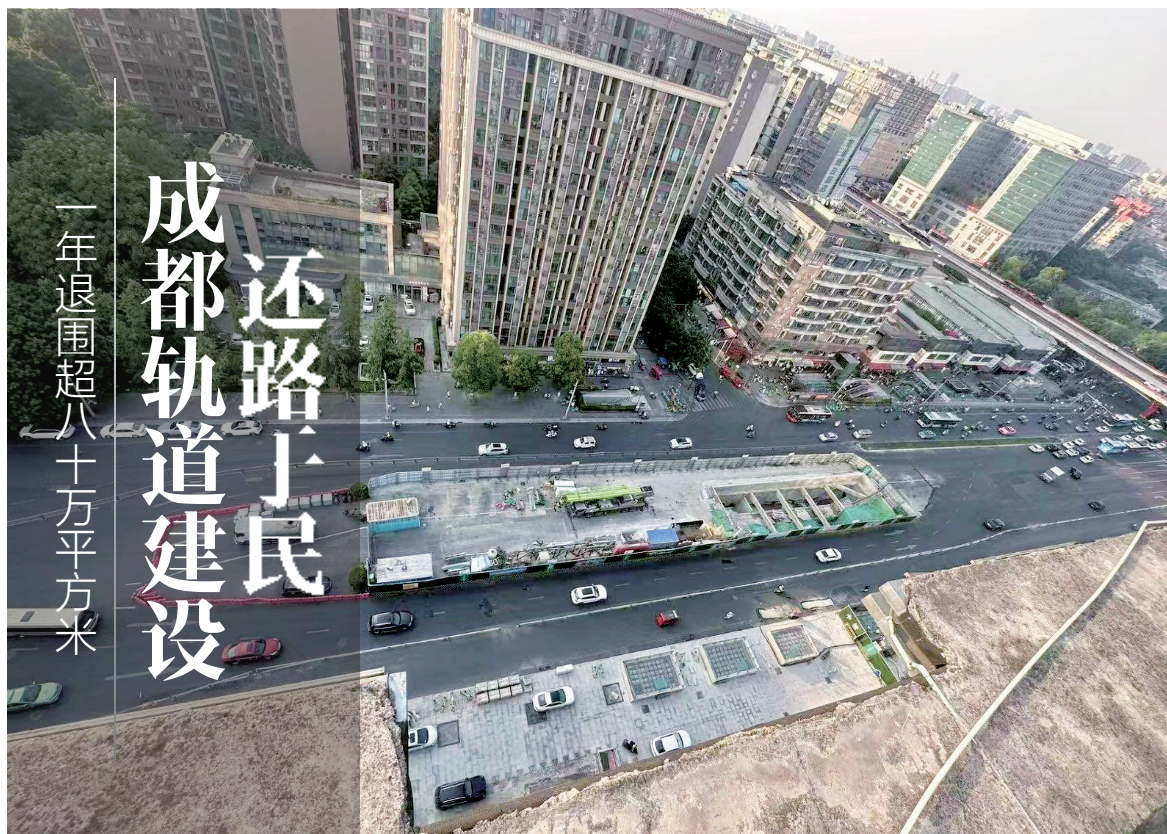
成都轨道交通10号线三期红牌楼站退围前情景。成都轨道集团供图
