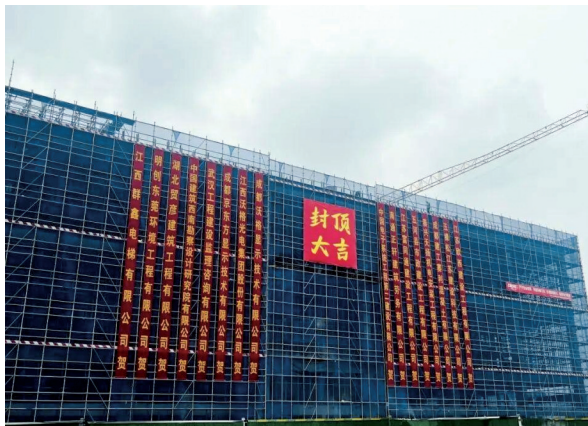
沃格光电 AMOLED 光蚀刻项目完成封顶。图据成都发布
