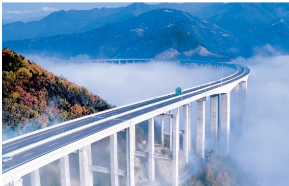
成都至九寨沟全程高速4小时直达，图为九绵高速平武涪江特大桥。蜀道集团供图
