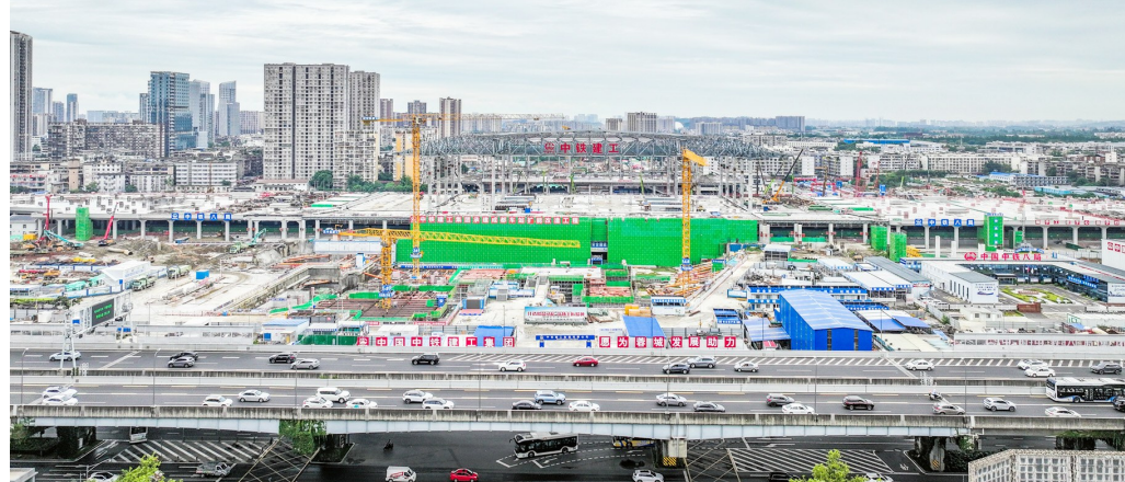
成都站改建工程施工现场。中铁建工集团供图
