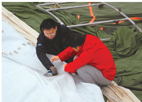
操作人员正在安装充气口。
