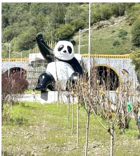
九绵高速白马隧道。
