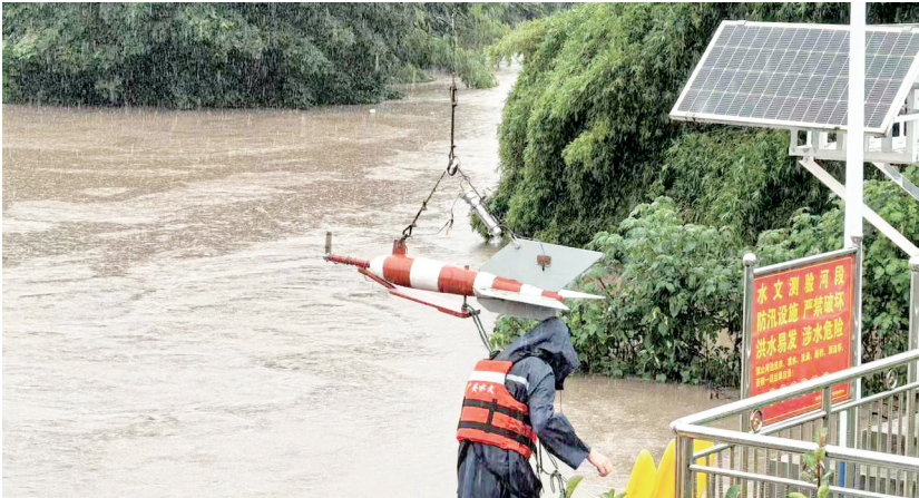
9月16日至24日,广安市遭遇持续强降雨,广安岳池水文测报中心工作人员在九龙水文站安装走航式ADCP(声学多普勒流速剖面仪)。 图据广安水文中心
