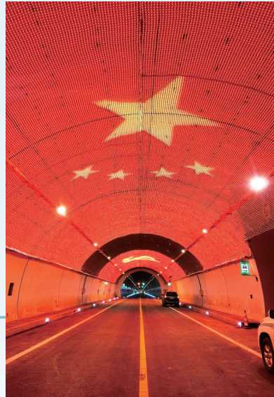
夹金山隧道内部。四川省交通运输厅供图
