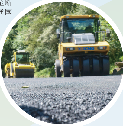
▲ 2019年7月27日,国道351线硃磧至夹金山公路实施改造工程。杨涛摄
