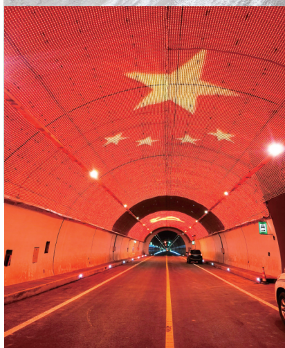
夹金山隧道内部。四川省交通运输厅供图
