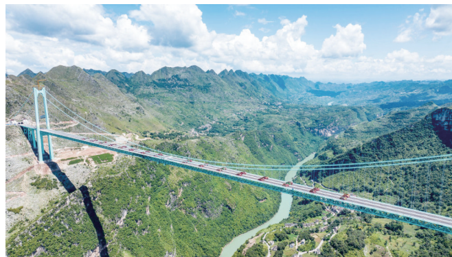
8月25日,花江峡谷大桥荷载试验正在进行。图据新华社客户端
