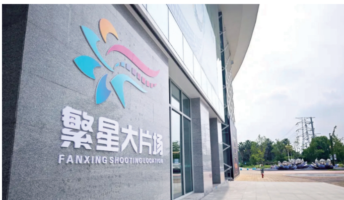
位于成都国际非遗博览园的繁星大片场。图据成都发布微信公众号
