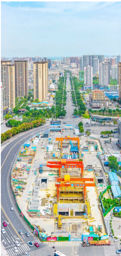
五洲广场站已全面完成结构施工。
