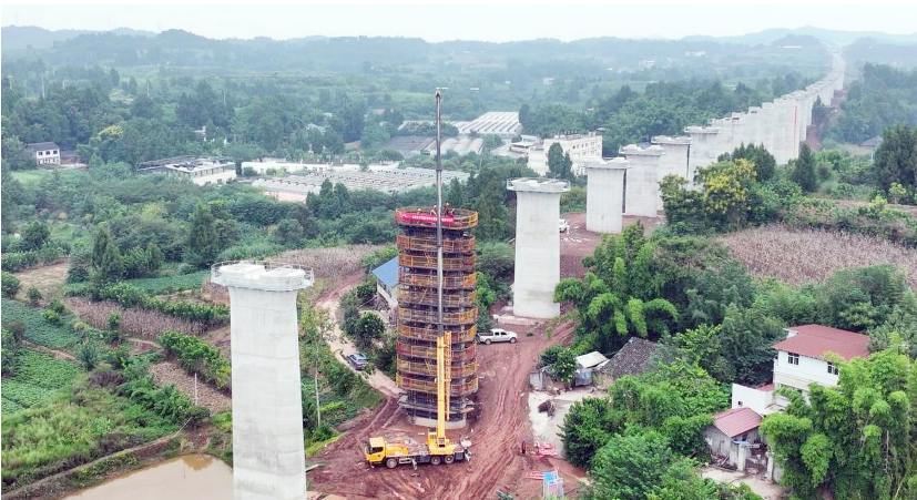
成渝中线高铁姚家坝特大桥最后一墩成功封顶。姚阳 摄
