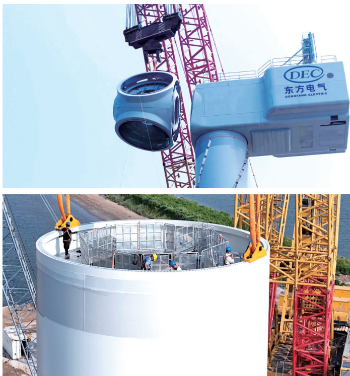
正在吊装的风力发电机。图据中国东方电器集团有限公司
