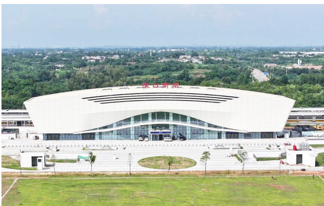
淮口南站 中国铁路成都局集团供图
