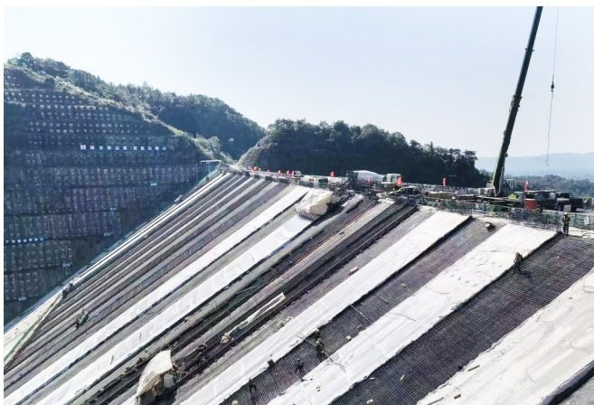
李家岩水库大坝面板浇筑施工现场。成都环境集团供图
