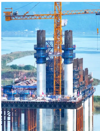
岷江特大桥墩柱施工。
