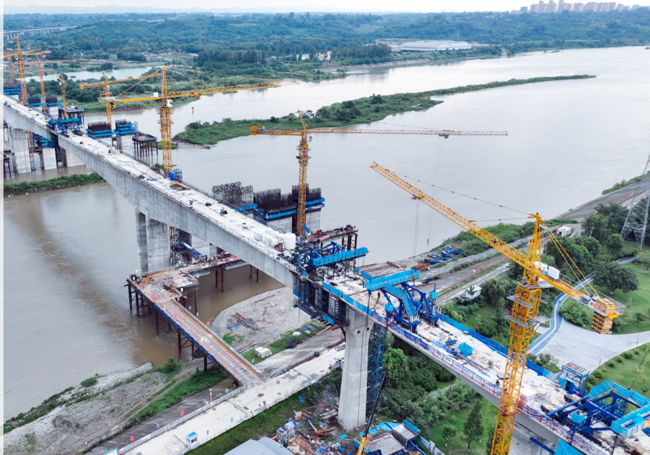
合龙后的岷江特大桥。
