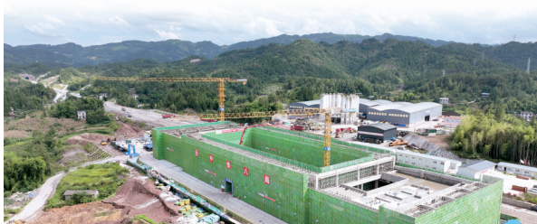
成达万高铁开江南站主体结构完工。成达万高铁公司供图
