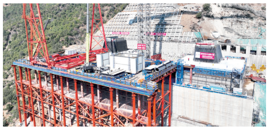
西香高速泸沽湖特大桥承台完工。蜀道集团供图
