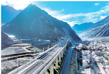
川青铁路。成兰铁路公司供图
