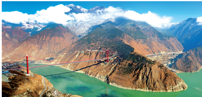
雅康高速泸定大渡河特大桥。四川省交通运输厅供图
