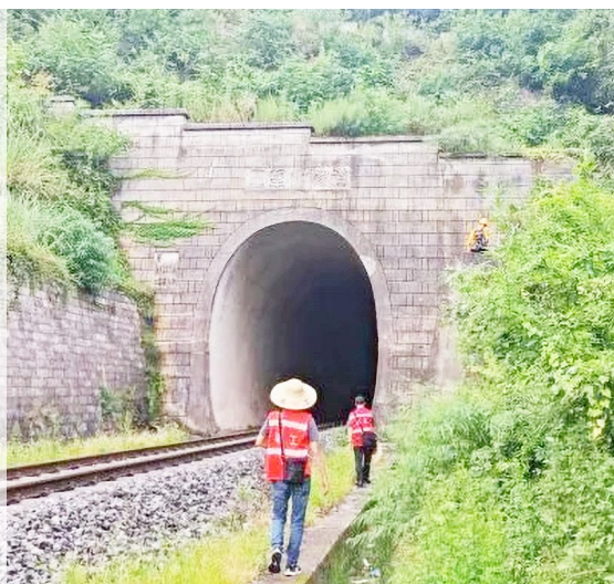
成都铁路局集团公司达州工务段职工对铁路沿线进行巡检。 何春蓉 摄
