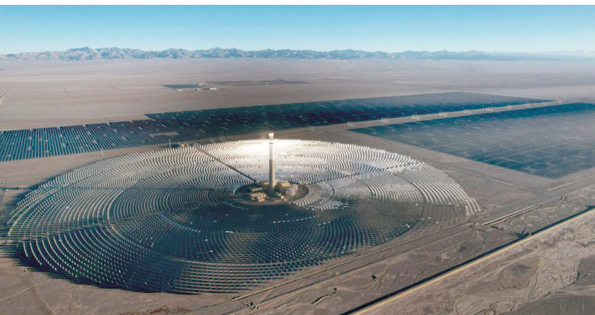
2024年11月30日拍摄的阿克塞汇东新能源光热+光伏试点项目(无人机照片)。
