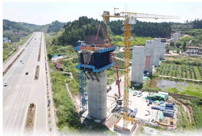
绵遂内铁路蒋家沟特大桥连续梁“0号块”成功浇筑。蜀道铁路投资集团供图
