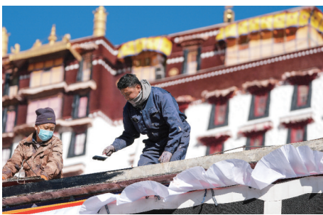
布达拉宫管理处维修科工作人员在粉刷墙体(2024年12月4日摄)。新华社发
