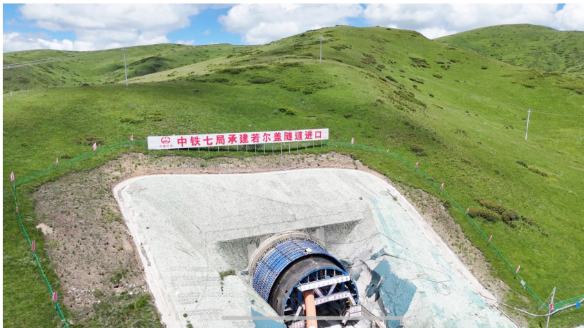
若尔盖隧道进口端。成兰铁路公司供图
