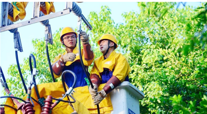
7月29日,简阳市河东新区10千伏放象Ⅱ线1号杆,国网简阳供电公司带电作业班与配电运检班人员协同配合,对该点位发热的线夹和引流线进行更换。
