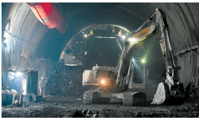
西宁至成都铁路红原2号隧道施工现场。
