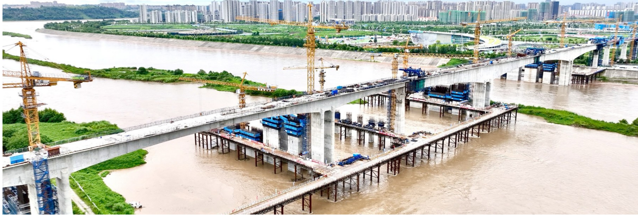
实现主跨合龙后的岷江特大桥。
