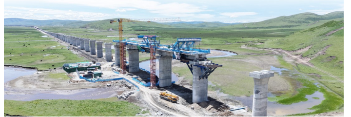
红原跨G213特大桥连续梁合龙施工现场。成兰铁路公司供图
