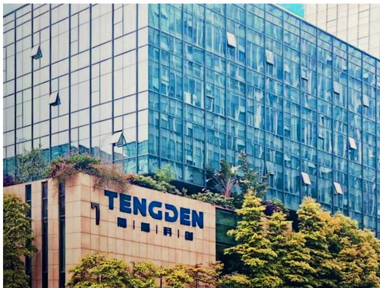
四川腾盾科技股份有限公司总部大楼。受访者供图
