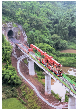
项目正线最后一根梁黄堰沟大桥架设现场。蜀道集团供图
