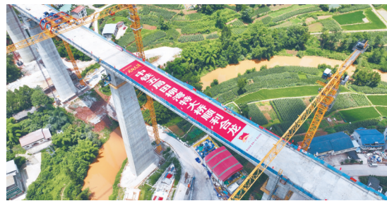
成渝中线高铁田柳湾特大桥连续刚构梁合龙部位。潘政吉摄
