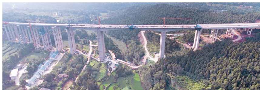
广绵高速扩容项目刘家咀特大桥双幅合龙。蜀道集团供图
