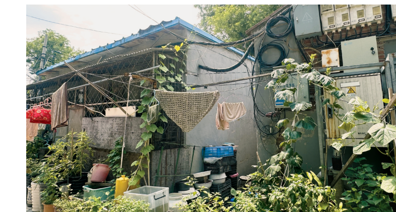
孚王府东西两路院落加盖严重、电线交错。
