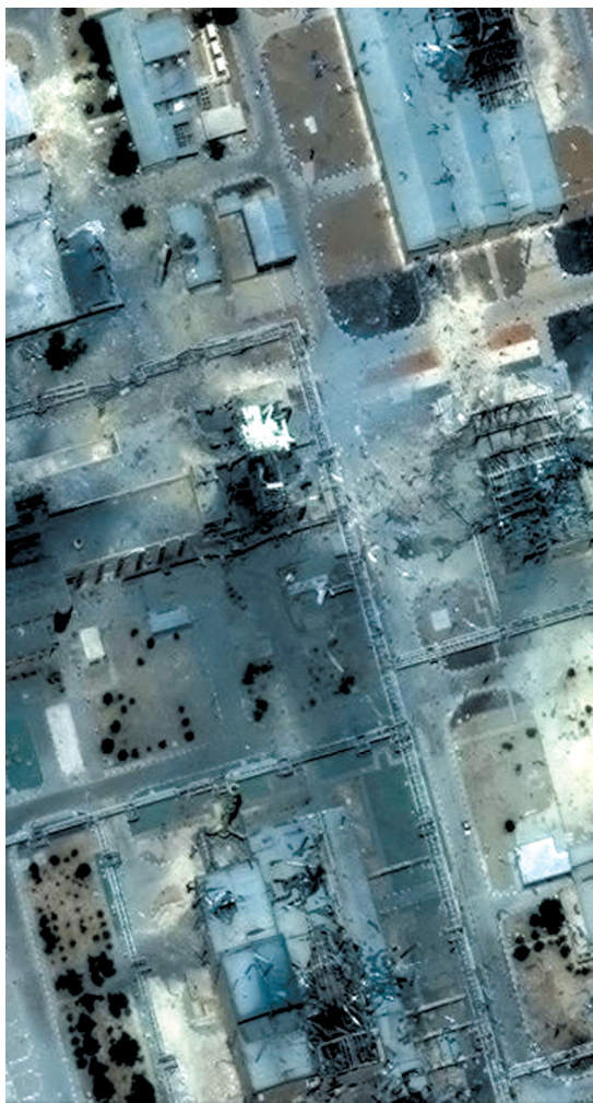
6月22日拍摄的卫星照片显示的是遭美军空袭后的伊朗伊斯法罕核设施部分区域。图据新华社客户端
