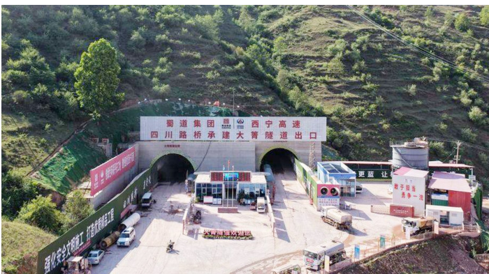
大箐隧道出口端。蜀道集团供图
