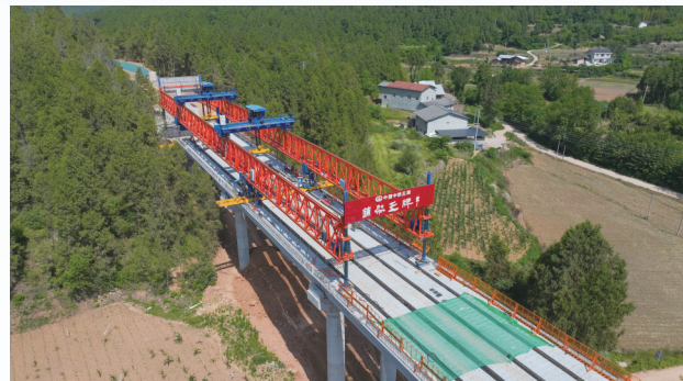
桥梁现场。中铁五局供图
