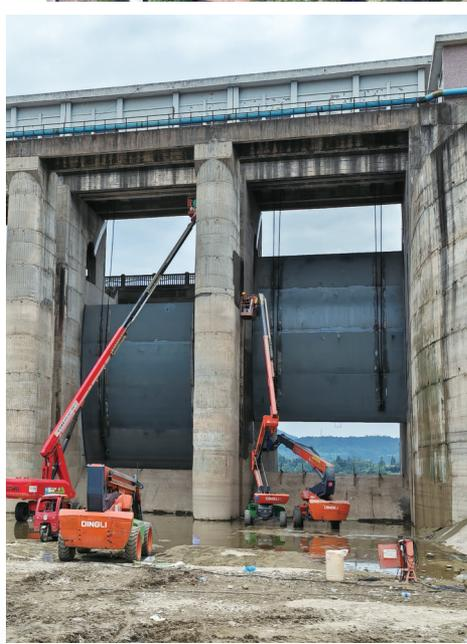
施工人员正在溢洪道吊装弧形闸门。
